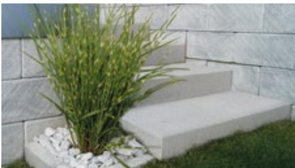
Blockstufe | Farbe: Zementgrau, feinst sandgestrahlt
